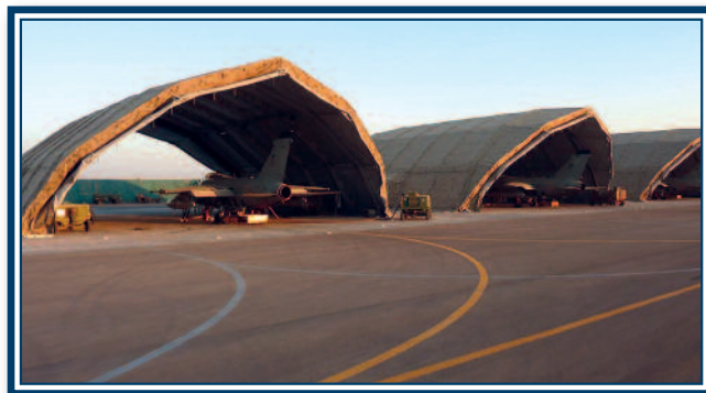
Allestimento hangar mobili presso Herat Afghanistan
