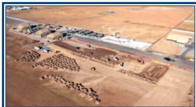
Costruzione strutture edificate e pista aeromobili presso Erbil
