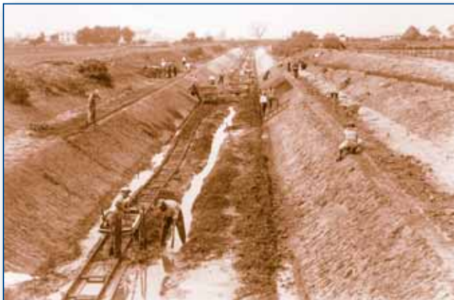
Realizzazione di uno dei tanti canali
