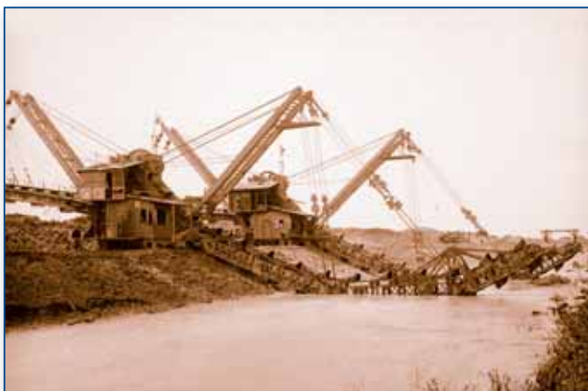
Escavatore Tosi in azione
