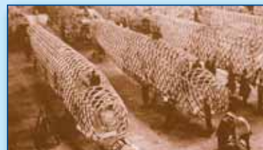
La costruzione geodetica delle fusoliere del Wellington
