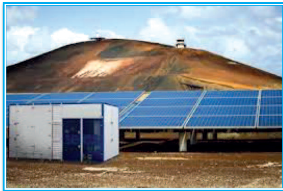
Il sistema AWA Modula può produrre 10.000 litri di acqua al giorno dall'umidità atmosferica
