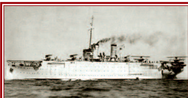
La Regia Nave Portaidrovolanti Miraglia dotata di due ponti di volo con catapulta
