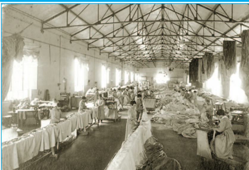
La lavorazione delle relature per il dirigibile NORGE N I
